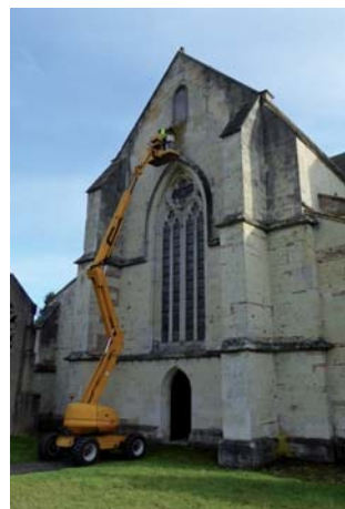
Constat de l'état des maçonneries à l'aide d'une nacelle en 2016
